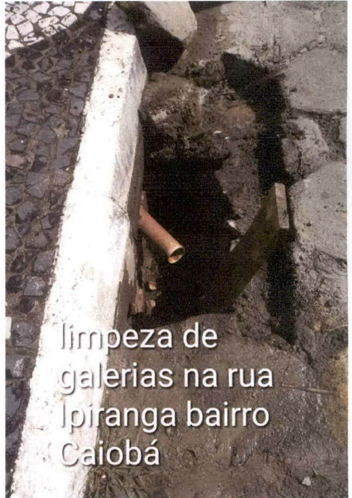
limpeza de galerias na rua Ipiranga bairro Caiobá
