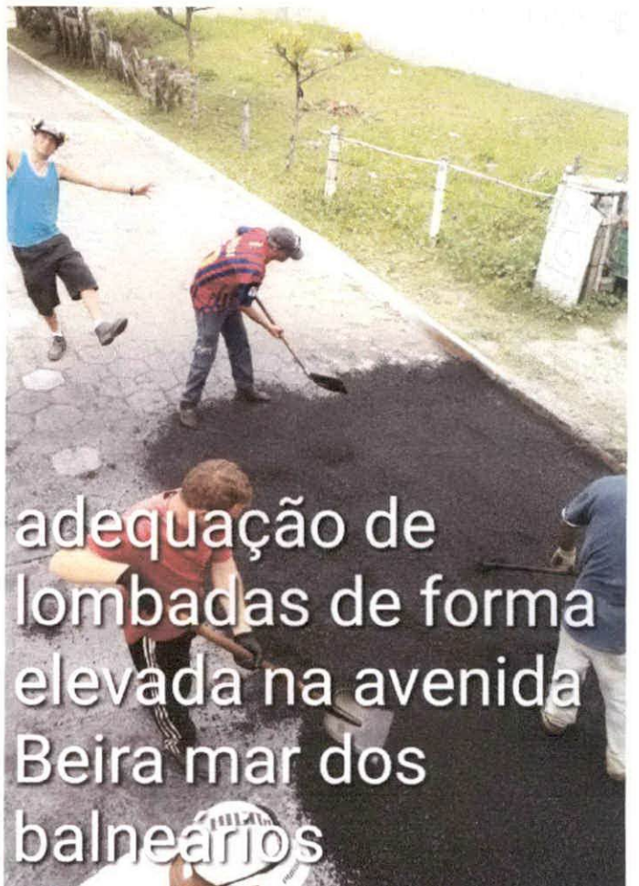
adequação de lombadas de forma elevada na avenida Beira mar dos balneários
