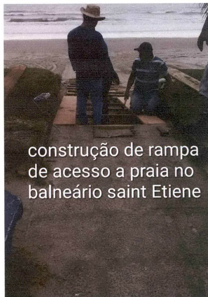
construção de rampa para acesso a praia no balneário saint Etienne
