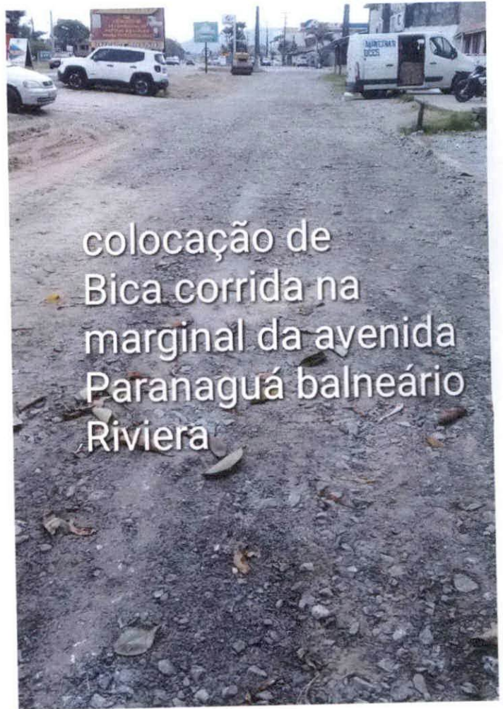
colocação de Bica corrida na rua E balneário Praia grande
