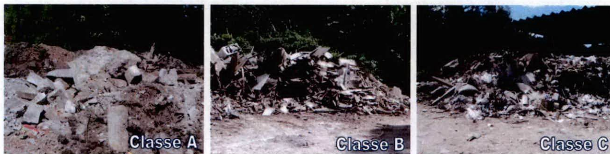
FIGURA 26: Segregação dos Resíduos de Construção Civil
