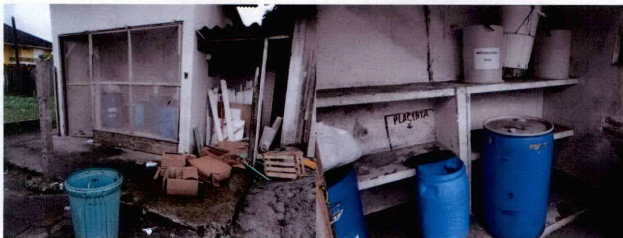
FIGURA 24: Armazenamento Temporário de Resíduos de Saúde do Hospital Municipal
