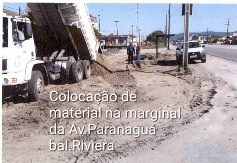
Colocação de Bica corrida na marginal da Av. Paranaguá bal. Riviera
