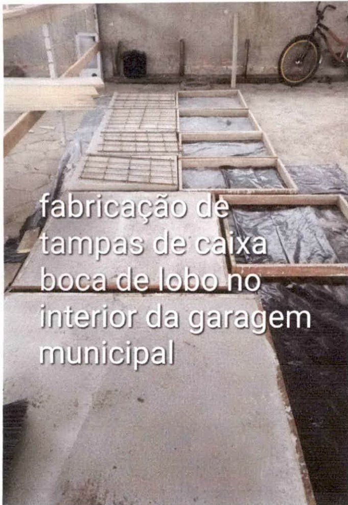
fabricação de tampas de caixa boca de lobo no interior da garagem municipal
