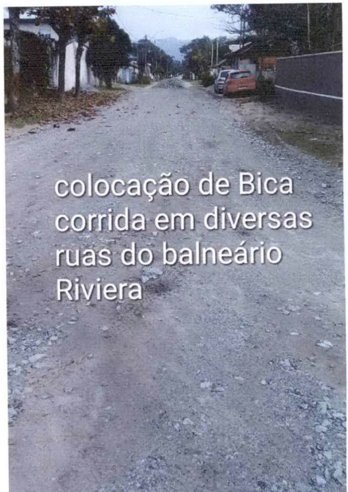
colocação de Bica corrida em diversas ruas do balneário Riviera
