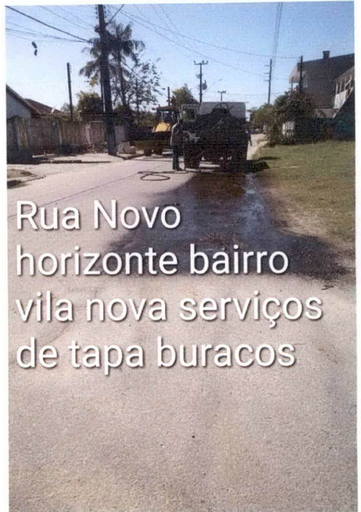
Rua Novo horizonte bairro vila nova serviços de tapa buracos
