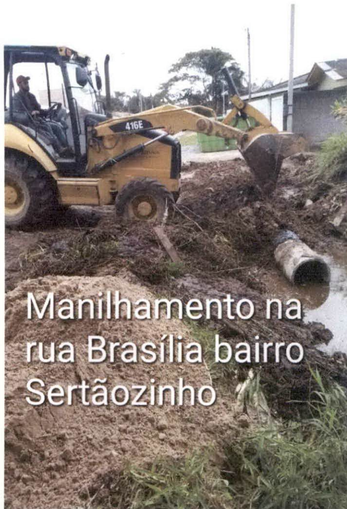
Manilhamento na rua Brasília bairro Sertãozinho
