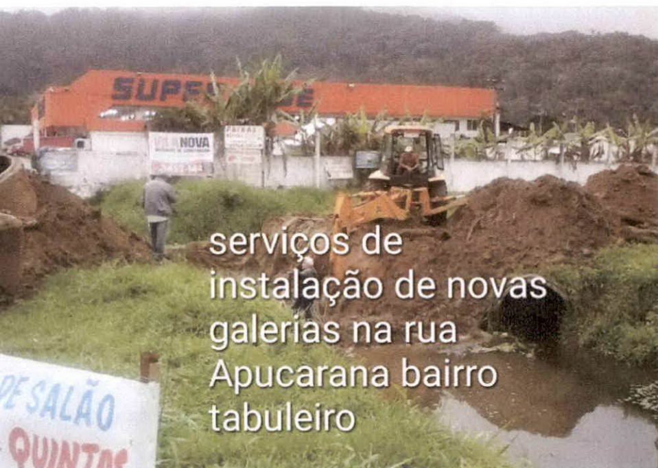
serviços de instalação de novas galerias na rua Apucarana bairro tabuleiro
