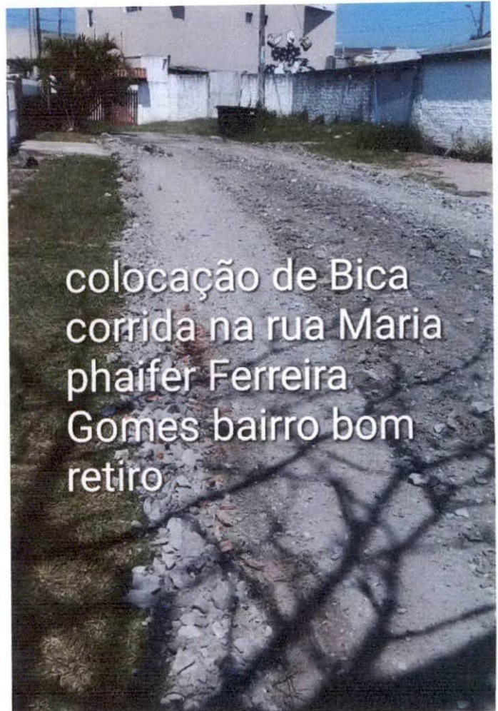
colocação de Bica corrida na rua Maria phaifer Ferreira Gomes bairro bom retiro
