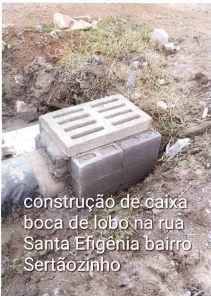
construção de uma caixa boca de lobo na rua Santa Efigênia bairro Sertãozinho
