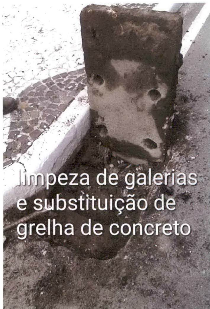
Rua Alvorada bairro Caiobá limpeza e substituição de grelha de concreto
