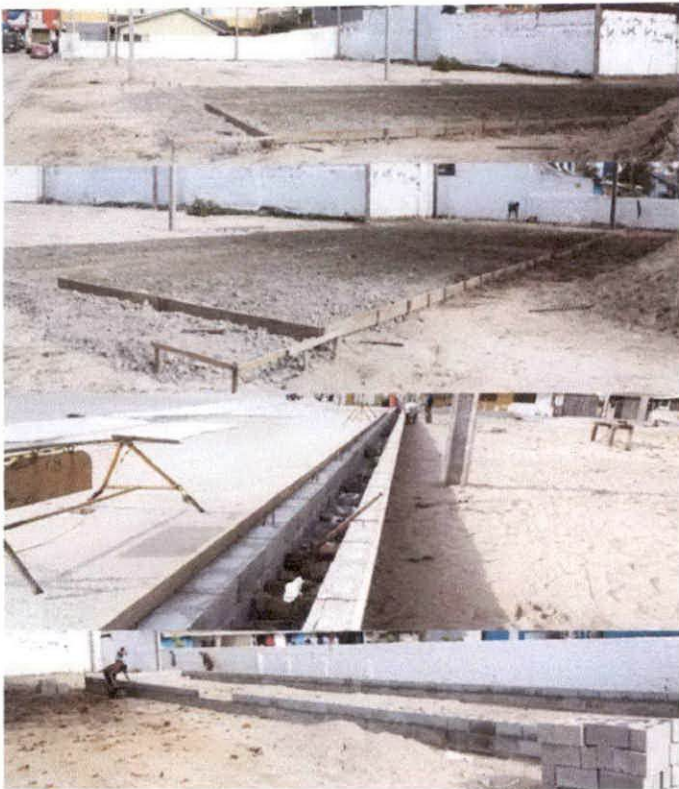
construção de caixa boca de lobo na rua Santa Efigênia bairro Sertãozinho
