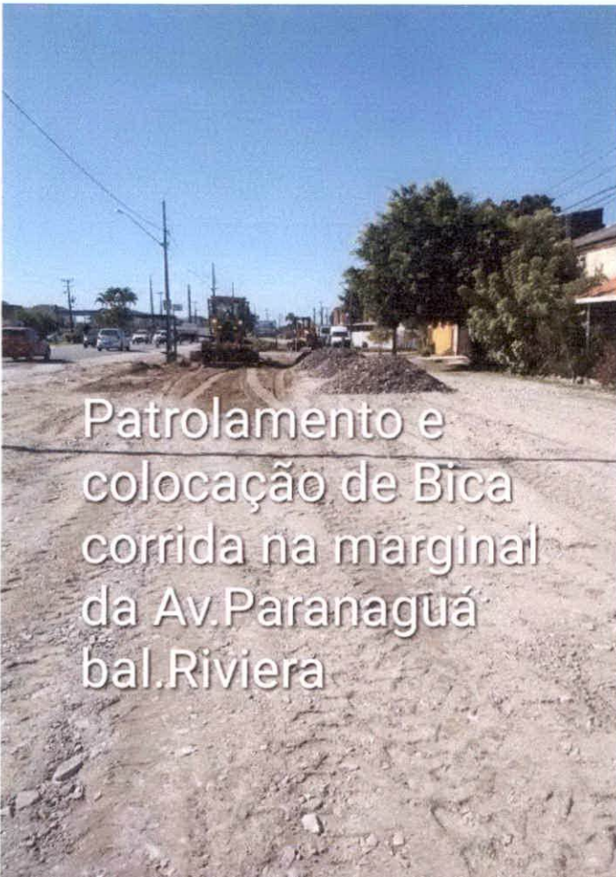
Patrolamento e colocação de Bica corrida na marginal da Av. Paranaguá bal. Riviera
