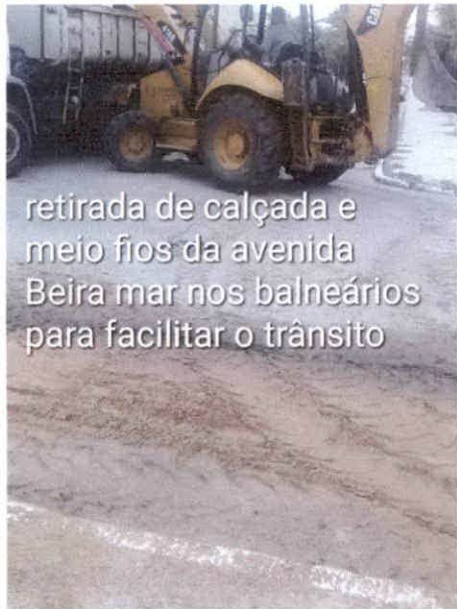
retirada de calçada e meio fios na avenida Beira mar dos balneários para facilitar o trânsito
