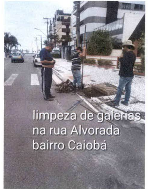
limpeza de galerias na rua Alvorada bairro Caiobá
