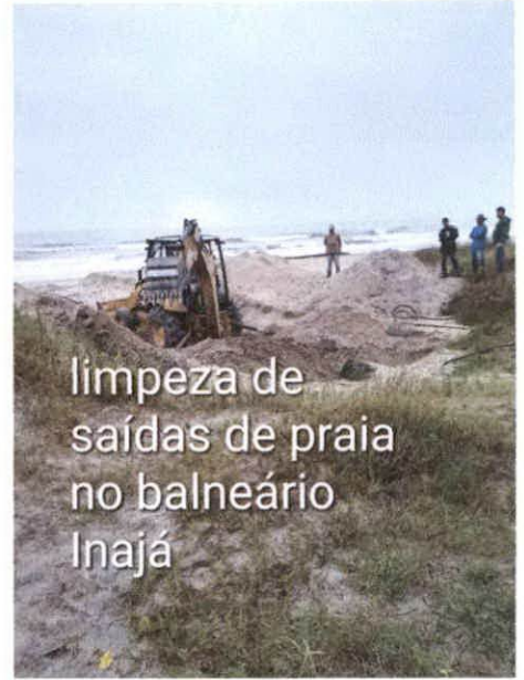
limpeza das manilhas de saídas de praia no balneário Inajá
