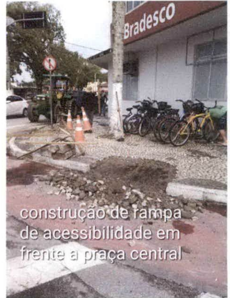
construção de rampa de acessibilidade em frente a praça central
