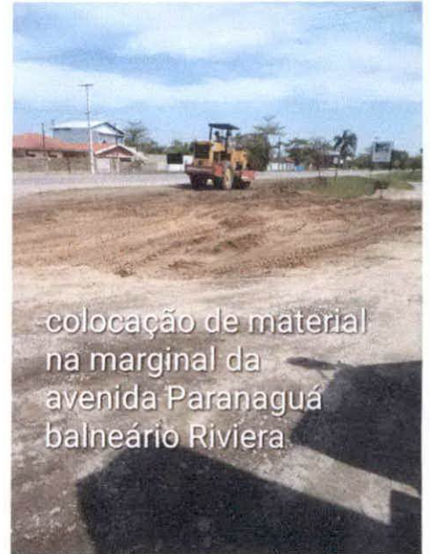
colocação de material na marginal da Av. Paranaguá balneário Riviera
