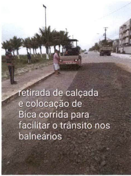
Retirada de calçada para facilitar o trânsito na avenida Beira mar dos balneários
