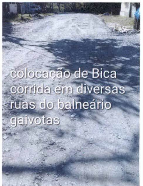
colocação de Bica corrida em diversas ruas do balneário gaivotas
