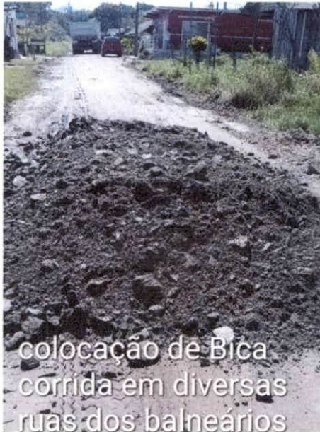
patrolamento e colocação de Bica corrida em diversas ruas dos balneários
