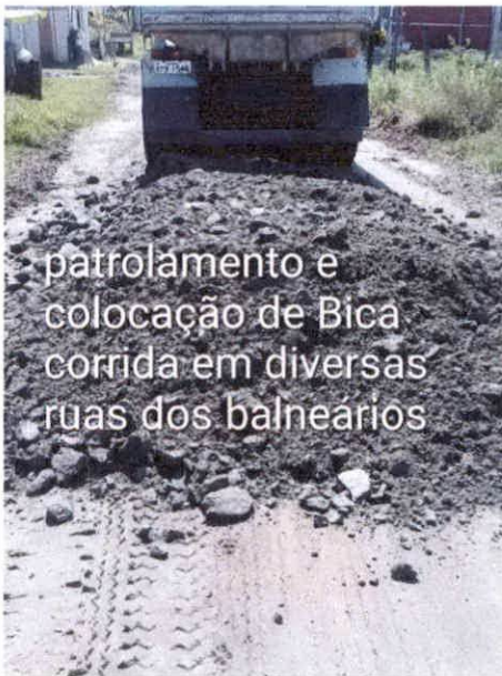
colocação de Bica corrida em diversas ruas dos balneários
