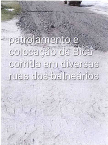
colocação de Bica corrida em diversas ruas dos balneários
