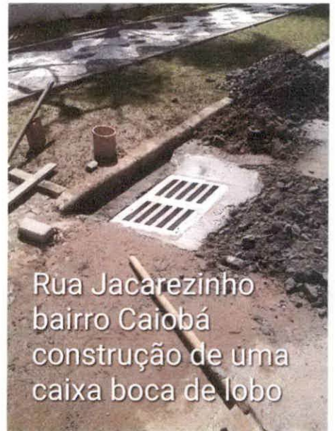
construção de caixa boca de lobo em diversas ruas do município
