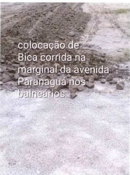
colocação de Bica corrida na marginal da avenida Paranaguá nos balneários
