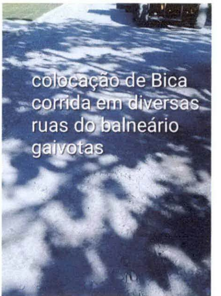
colocação de Bica corrida em diversas ruas do balneário gaivotas
