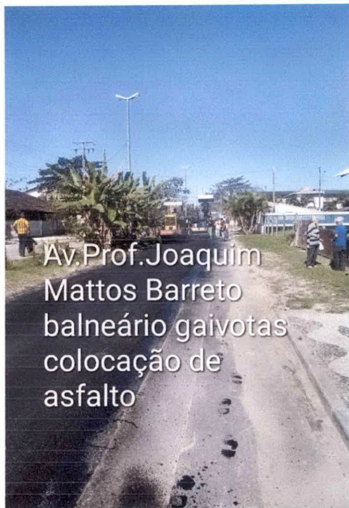
Av.Prof.Joaquim de Mattos Barreto balneário gaiivotas colocação de asfalto
