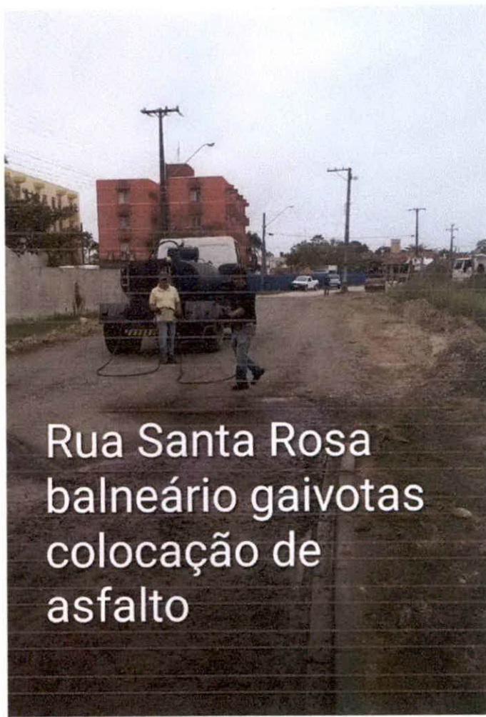
Rua Santa Rosa balneário gaivotas colocação de asfalto
