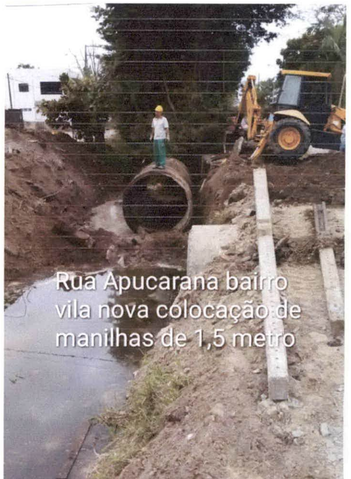
Contenção na rua Apucarana bairro vila nova
