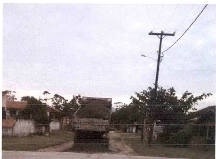
Rua 7 de setembro balneário Riviera colocação de Bica corrida
