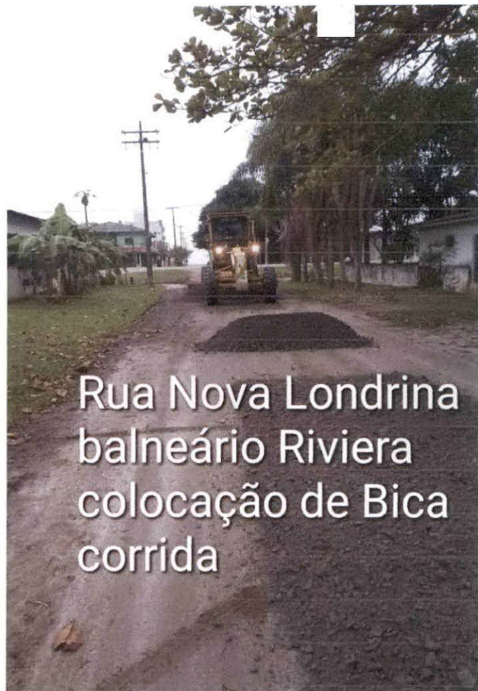
Rua Nova Londrina balneário Riviera colocação de Bica corrida
