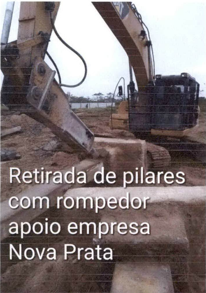
Retirada de pilares com rompedor apoio empresa Nova Prata
