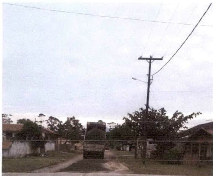
Rua 7 de setembro balneário Riviera colocação de Bica corrida
