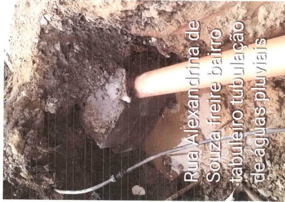
Rua Alexandrina de Souza freire bairro tabuleiro tubulação de águas pluviais
